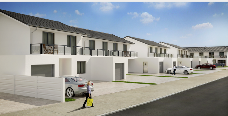
Bauteil 1: Reihenhauser 1 – 3 Fertigstellung Sommer 2016
